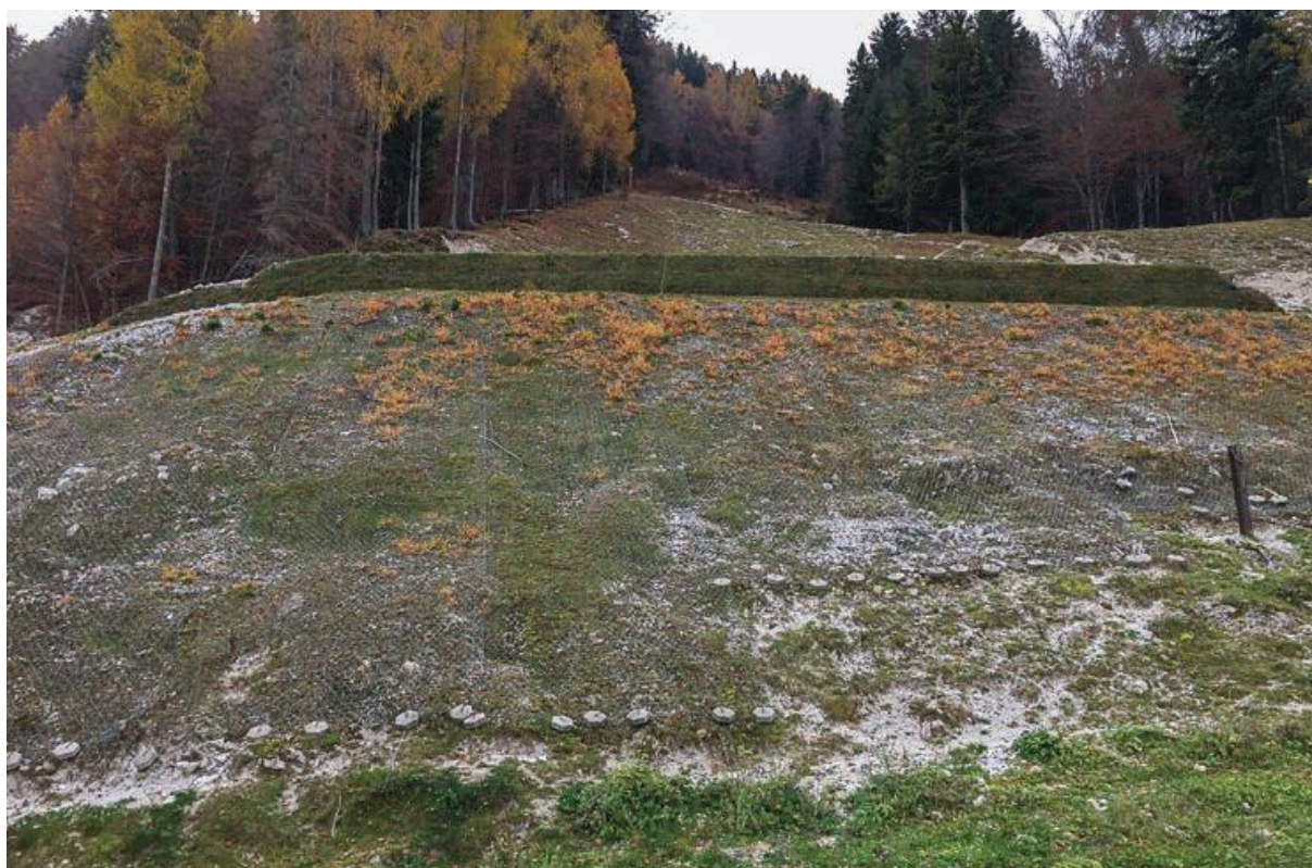
Slika 4: Konstrukcija za preprečevanje erozije, prodiranja in drsanja tal na smučišču Kranjska Gora.
